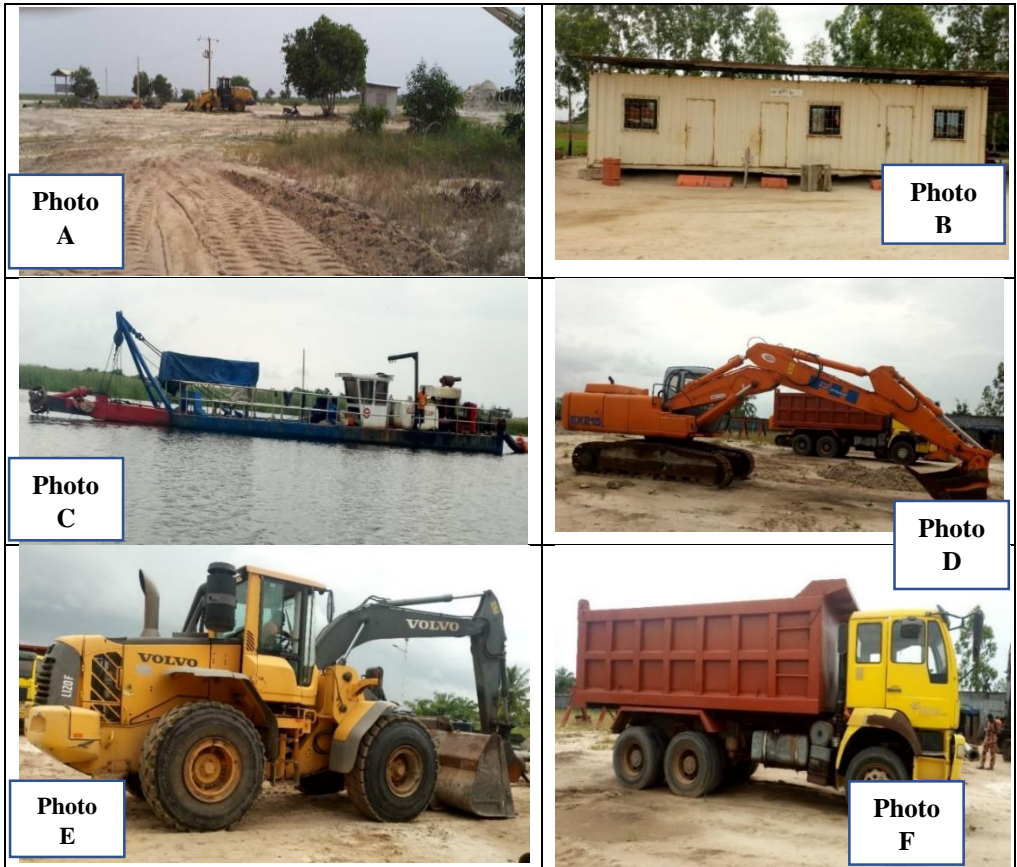
Planche 1 : Quelques équipements-type installés sur les sites de dragage de la zone Prises de vues : GUELNODJI, décembre 2019 et CHODATON, avril 2021
